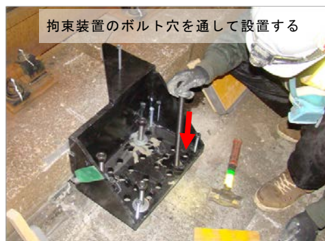
図 15 アンカーボルトの設置
