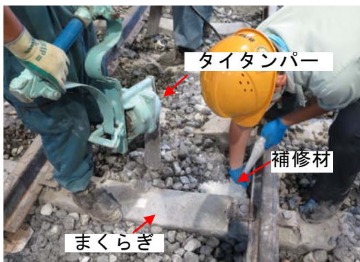
図6 ポリマー安定処理工法の施工状況
