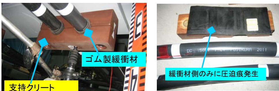
(a) 加振装置への架設状況（手法 B） (b) 加振試験後の供試体の状況（手法 B）
