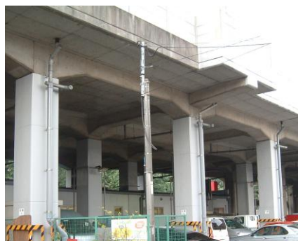
図2 高架橋柱の鋼板巻き立て補強
