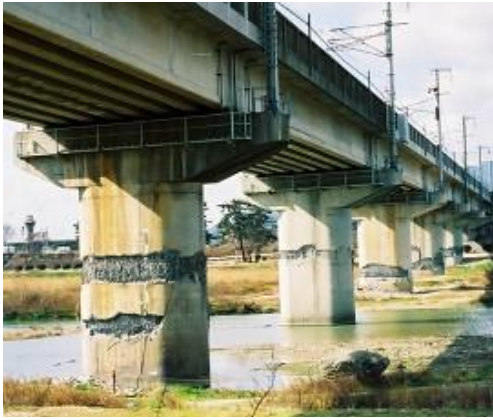
図6 橋脚の被災例
