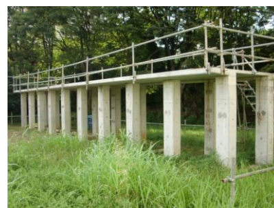
図4 柱試験体 3) の外観
