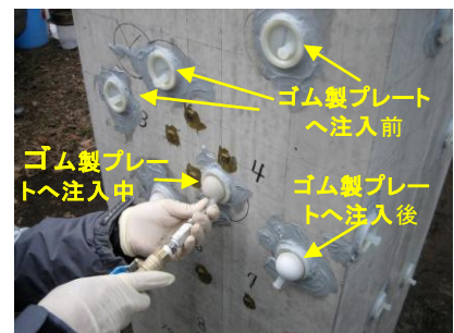
図 5 ASR によるひび割れ注入材施工状況
