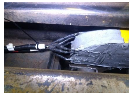
クロッシングの先端部の状況
