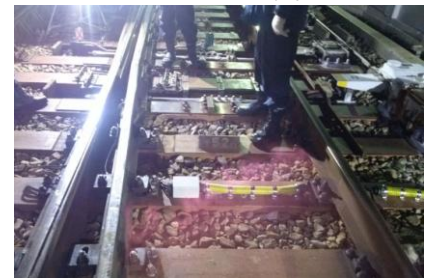
ケーブルの敷設状況
