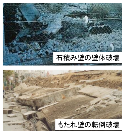
図3 もたれ壁・石積み壁の破壊事例 1)
