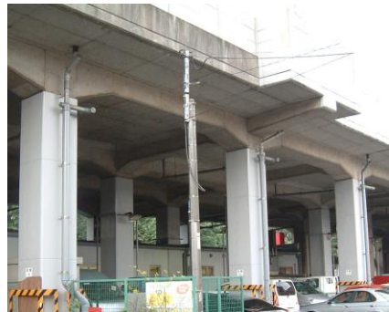
図2 高架橋柱の鋼板巻き立て補強
