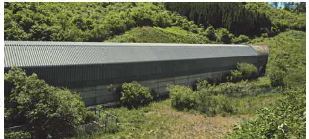
図 1 新幹線におけるスリット付シェルターの設置例
