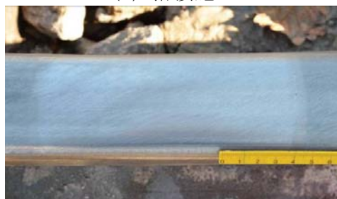
(b) 施工後の外観
