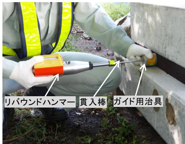
図 4 衝撃貫入試験の状況
