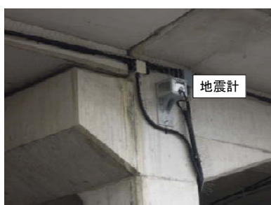
図6：地震計の設置
