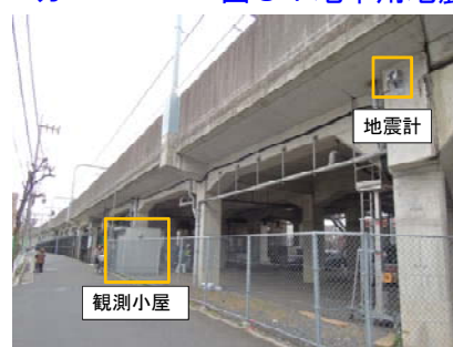
図10：観測小屋と高架上の地震計の状況
