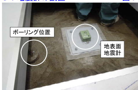
図9：地表面への地震計の設置
