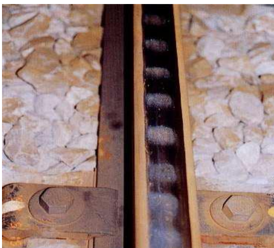
図 1 レールの波状摩耗
