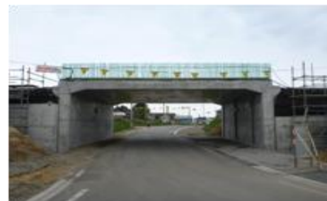
図-13 北海道新幹線の補強盛土一体橋梁
