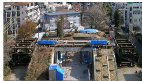
図-9 水平載荷試験状況写真
