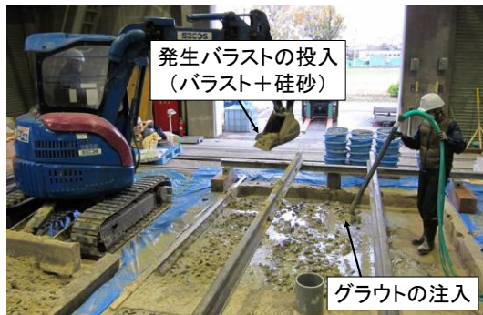
(a) 発生バラスト改良路盤
