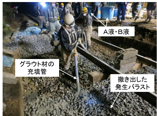
図10 グラウト材の注入
