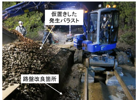
図9 発生バラストの撒き出し
