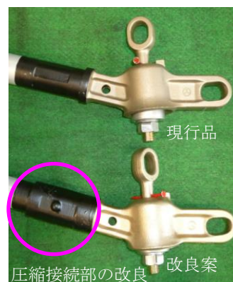
図3 曲線引金具の強度向上
