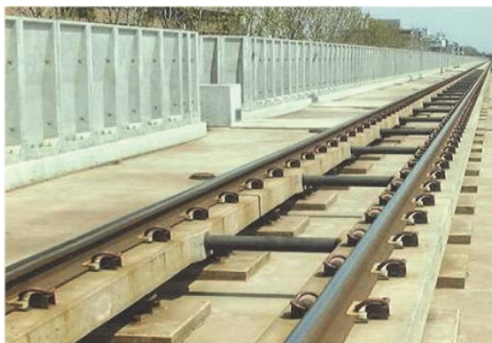
フローティング・ラダー軌道
