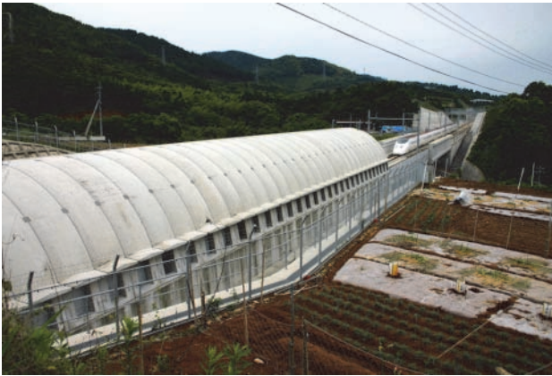
図8 トンネル微気圧波低減対策（緩衝工と先頭部）
