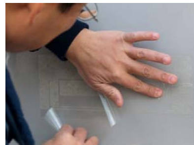
図7 塗布箇所を型抜きした粘着シートの貼付け
