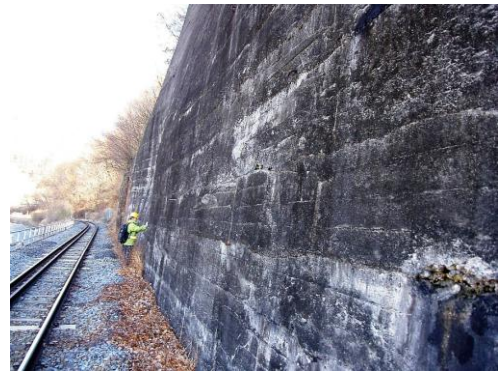
図1 切土のり面工(張コンクリート)の例
