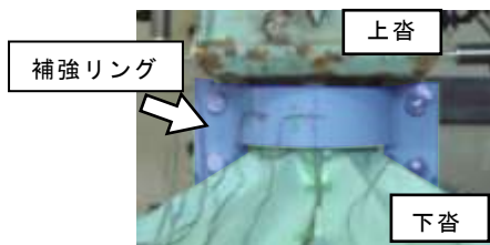
図8 補強リングの設置状況
