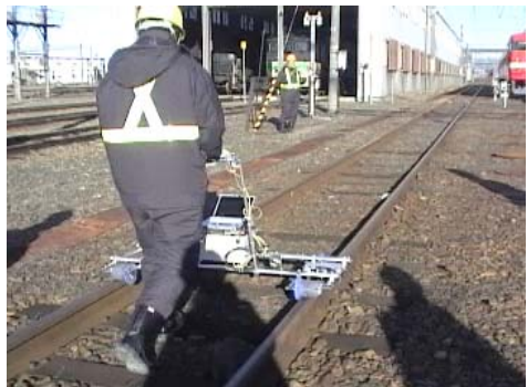
図7 現地試験の状況
