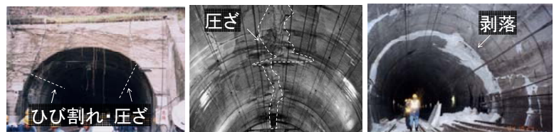
(a)東山トンネル (b)妙見トンネル (c)魚沼トンネル
