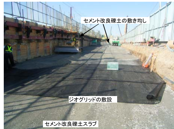
図5 セメント改良礫土スラブの施工の様子
