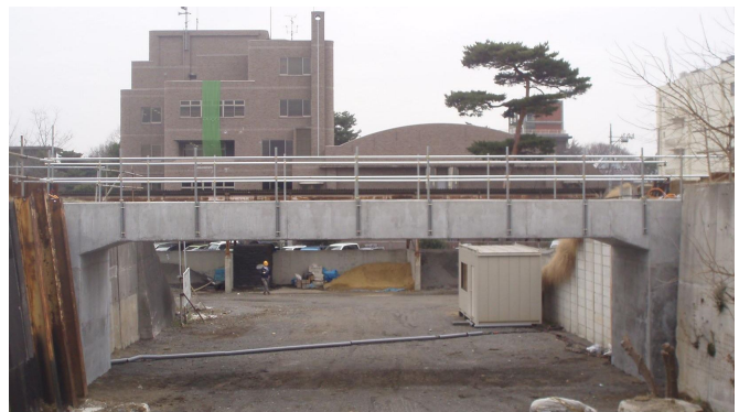
図2 補強土併用インテグラル橋梁
