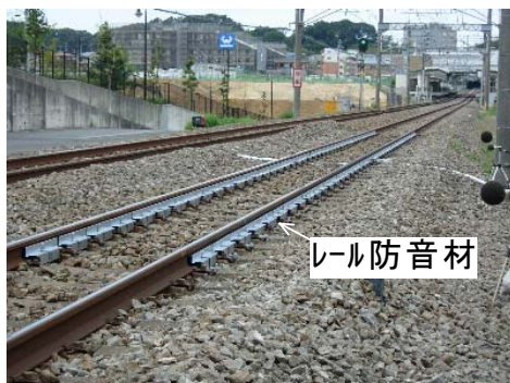
図 5 レール防音材の敷設状況
