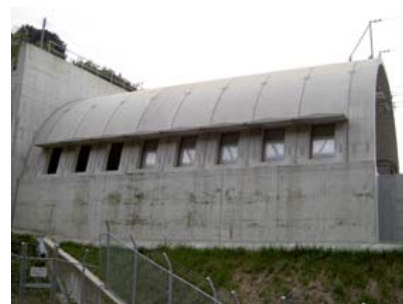
図 1 トンネル緩衝工
