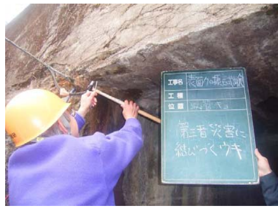
図7 不健全部のコンクリート表面加振試験状況
