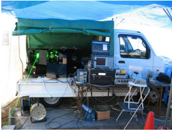
図2 レーザー超音波探傷システムのプロトタイプ
