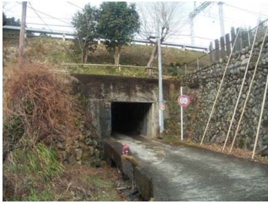
図6 検査対象となるボックスカルバート
