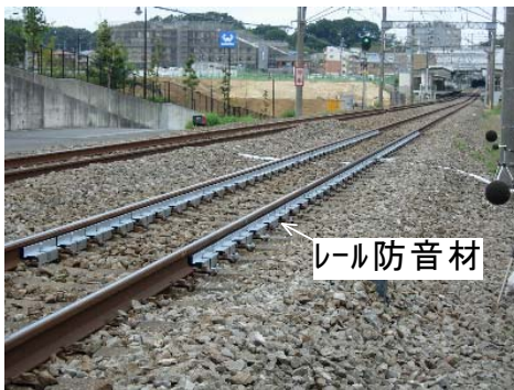
図 5 レール防音材の敷設状況
