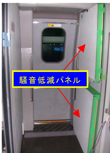
図4 パンタグラフ部騒音低減試験（明かり区間）
