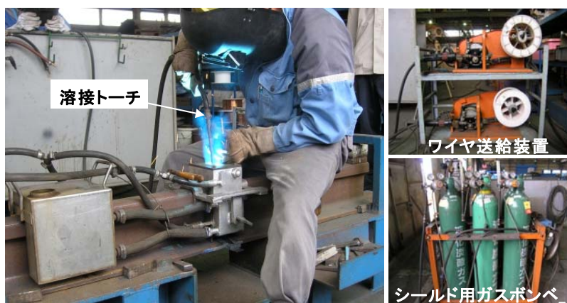
図5 半自動エンクローズアーク溶接の作業状況と装置
