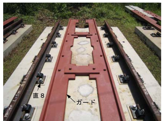
図5 平板スラブへの取り付け状況
