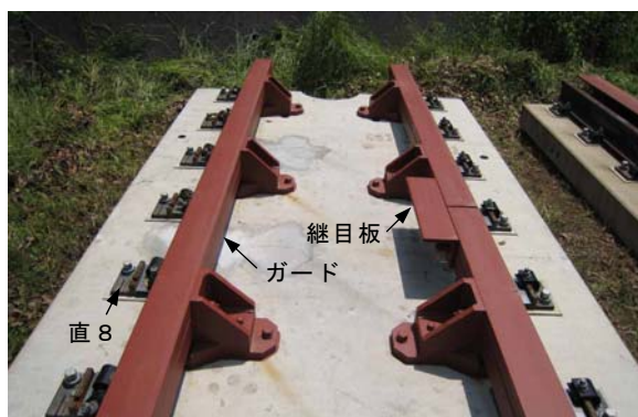
図2 平板スラブへの取り付け状況
