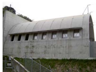
図 1 トンネル緩衝工
