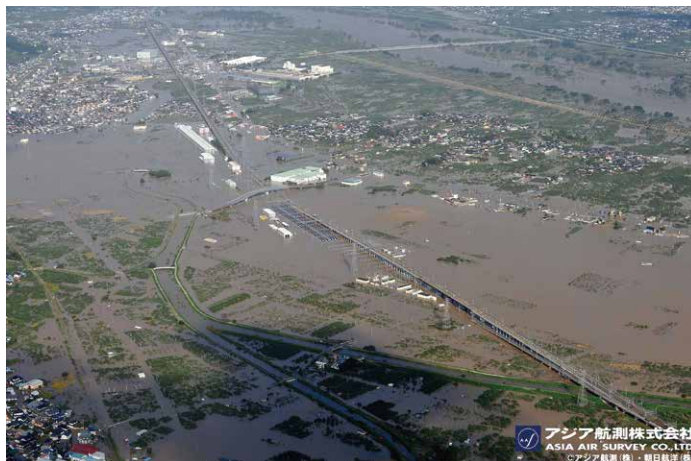
図3 令和元年東日本台風による被災事例 (撮影：©アジア航測(株)・朝日航洋(株))
