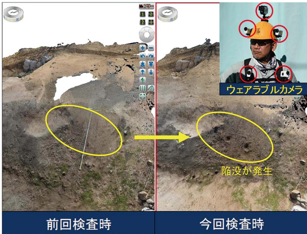
図15 VR技術を用いた盛土の検査の実験例
