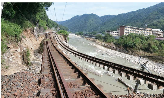
図1 平成30年7月豪雨での被災事例
