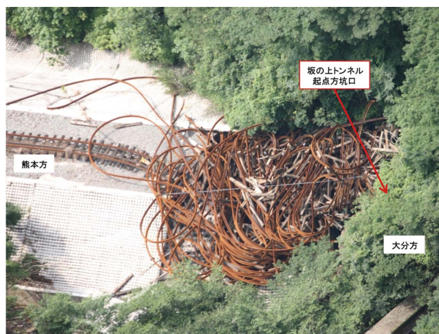
図3 平成24年九州北部豪雨による鉄道の被災事例
