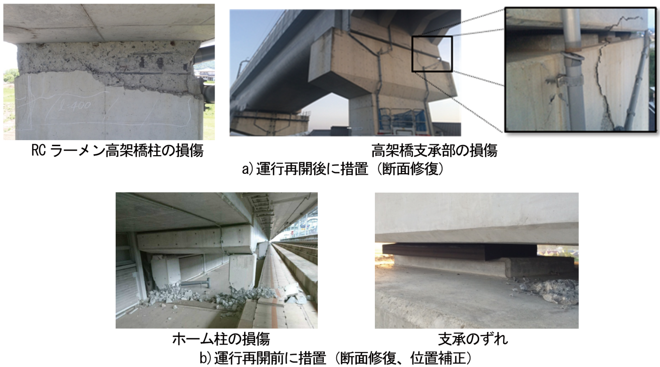
図 14 熊本地震により被災した九州新幹線高架橋の診断に関する技術支援
