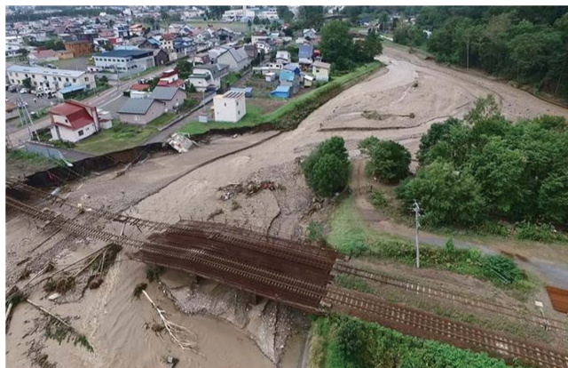
図4 台風10による被害例(河川橋梁)
