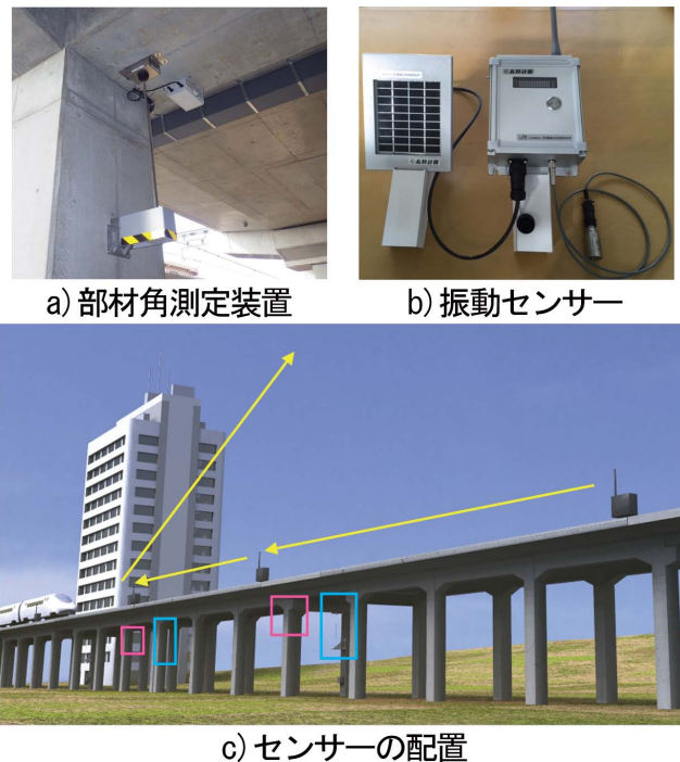
図12 RC ラーメン高架橋柱の損傷検知システム （水色：部材角測定装置、ピンク：振動センサー）
