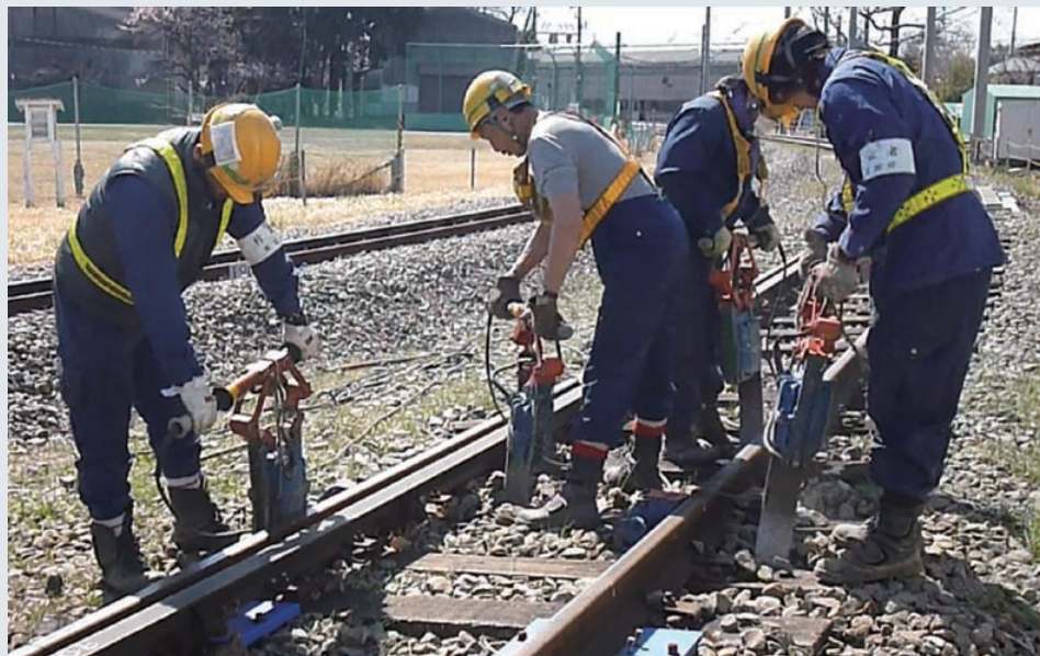
図2 小型のつき固め専用機械を用いたつき固め作業
