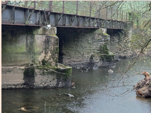
Network Railのノース・デボン線の橋りょうNDN 197.79に監視システムの現地試験の一環としてAI対応カメラが設置された。《出典 Railway Gazette International》
