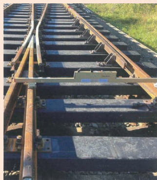
チェコの Loučna nad Desnou で分岐器に敷設された STRAILway 30 プラスチックまくらぎ
