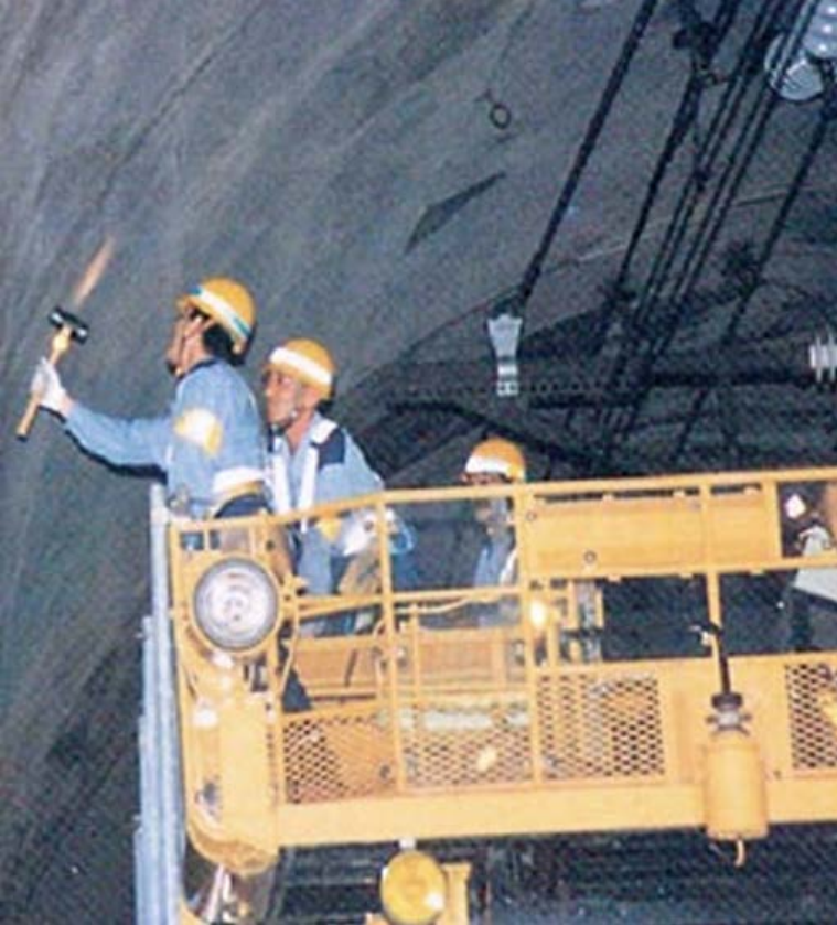
図2 トンネル覆工表面の近接目視と打音調査
