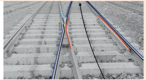
クロッシング部における測定生データの一例。自動データ解析の基礎となる。
