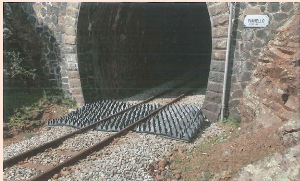
コルシカの鉄道トンネルに設置されたユニバーサルプレート 《出典 Der Eisenbahningenieur》
