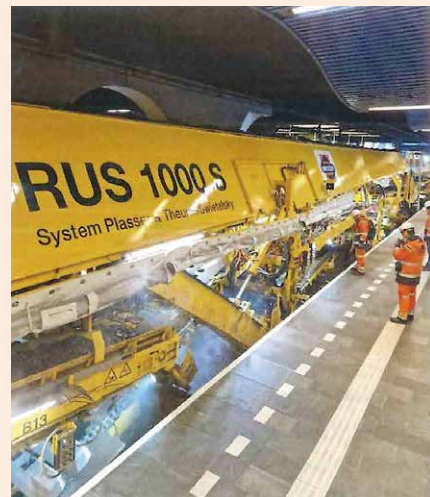
ロッテルダムのブランク地下鉄駅における粉塵低減軌道工事 《出典 Eisenbahntechnische Rundschau》
