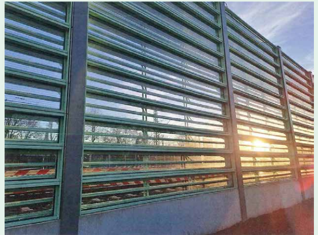
ハンブルグ S4 線での MetaWindow Hs-MwP の現地試験 《出典 Der Eisenbahningenieur》
