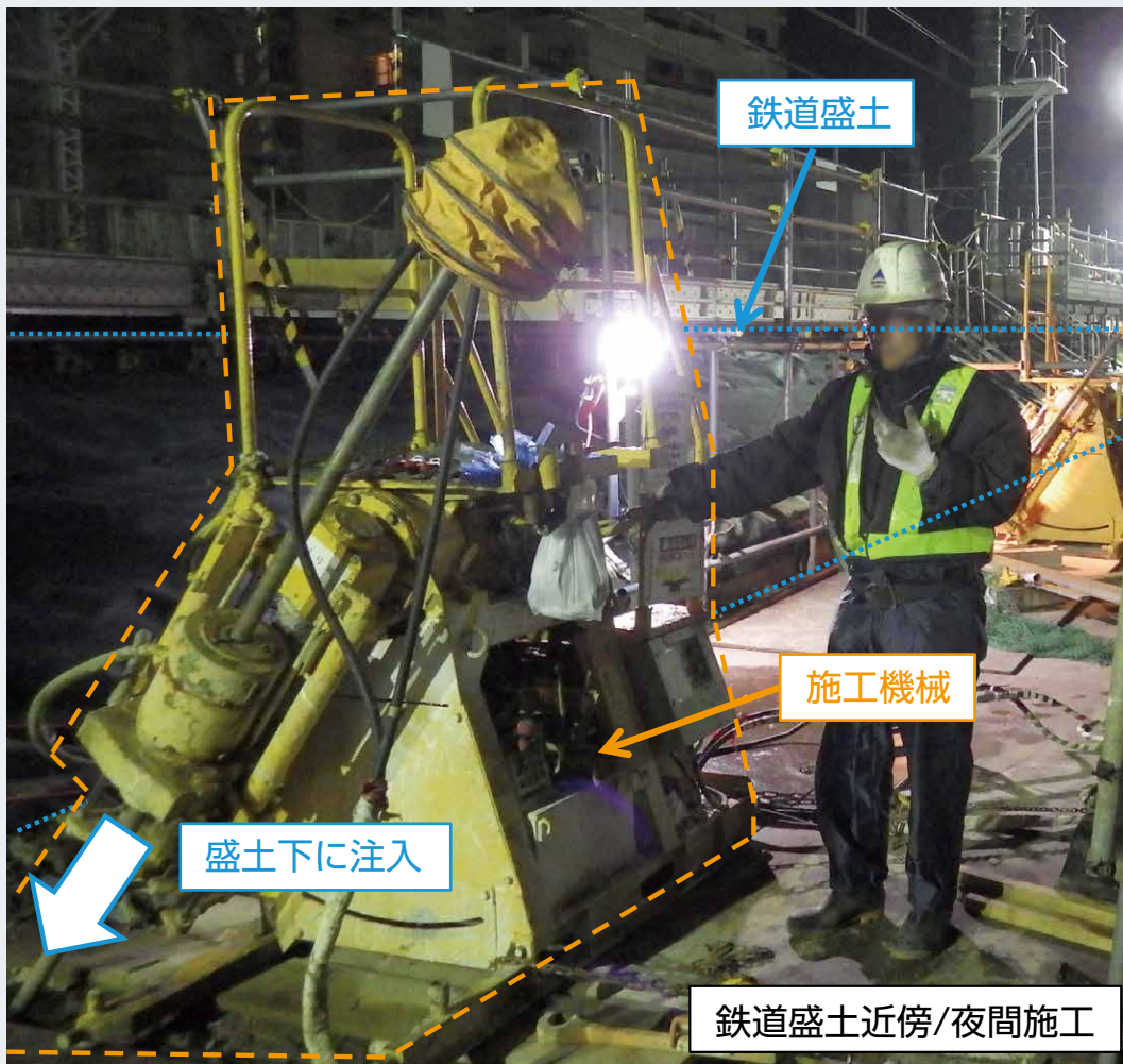
図3 脈状地盤改良工法 施工の様子
