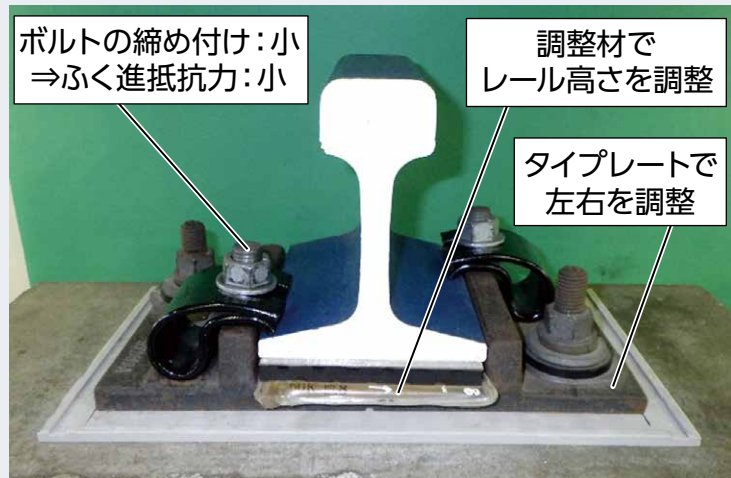
(b) スラブ軌道用(直結8形締結装置)
