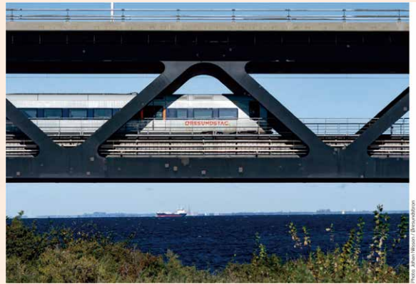
Strainlabs 社は試験運用でエーレスンド橋の線路上に設置されたボルトを監視している。《出典 Railway Gazette International》
