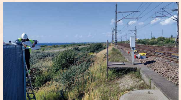
Strainlabs 社のルーターはペーバーホルムに設置されており、2つのアンテナが異なる方向を向き、粒子磁石に取り付けられたボルトからの予圧のデータを受信する。《出典 Railway Gazette International》
