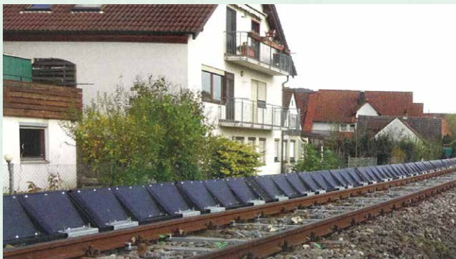
極めて低い防音壁はアンマータールの鉄道沿線ではほとんど目立たず景観に完全に溶け込み、住宅街の平和と静けさを確保している (画像の出典: KRAIBURG STRAIL 社) 《出典 Eisenbahntechnische Rundschau》
