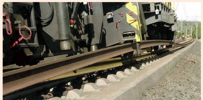
ケルン - ライン / マイン高速線で稼働中の Vossloh 社のレール交換システム 《出典 Der Eisenbahningenieur》
