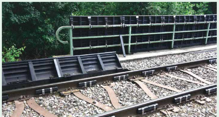
橋りょう付近に設置されたレールダンパー、高さ 55cm のミニ防音壁、手すりの隙間の充填の組み合わせにより、ニーダーザクセン州西部の住宅街付近の静寂が確保されている (画像の出典: KRAIBURG STRAIL 社) 《出典 Eisenbahntechnische Rundschau》
