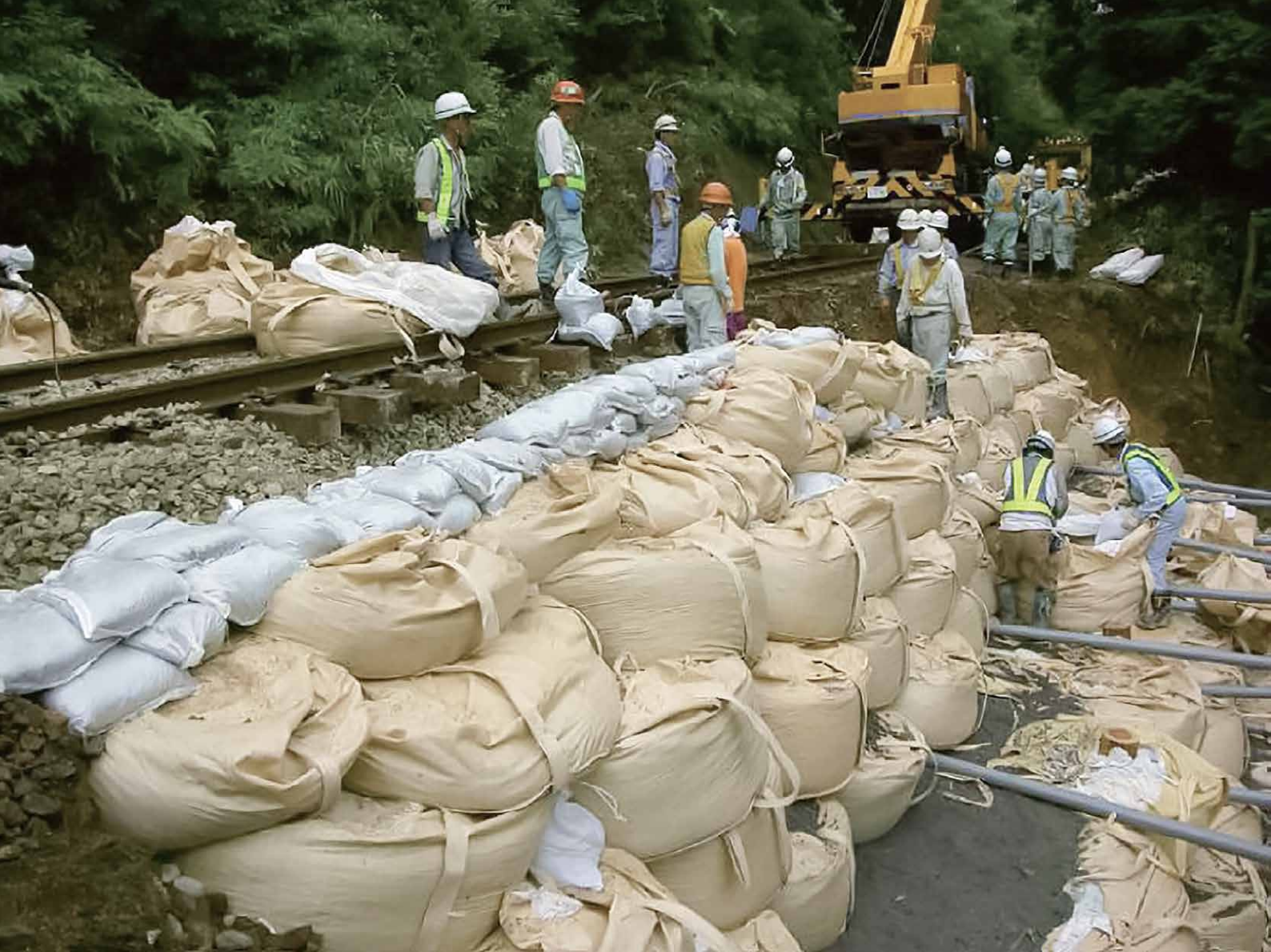
図7 大型土のうによる応急復旧の例 6)
