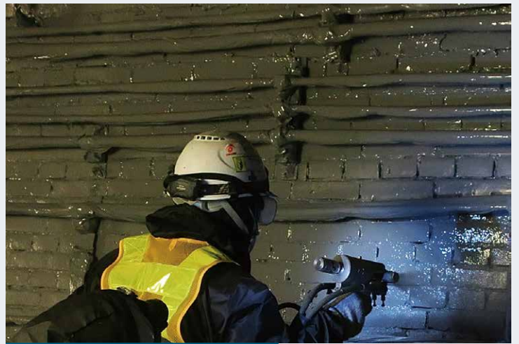
図5 ポリウレタ樹脂の吹付け
