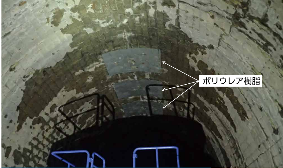
図16 施工から7年経過後のポリウレア樹脂吹付け工法 4)
