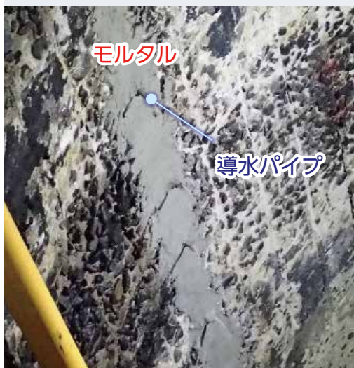
図18 漏水を逃がす工夫 4)
