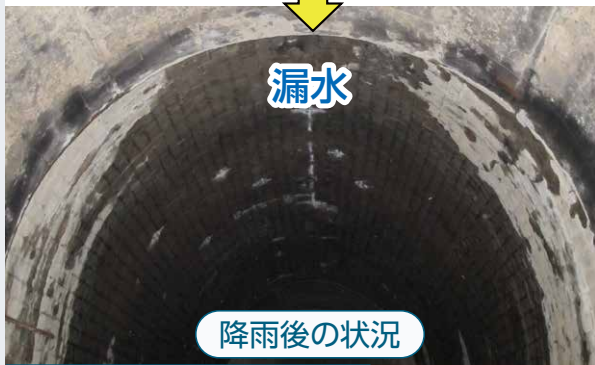
図9 トンネルの漏水の例 2)
