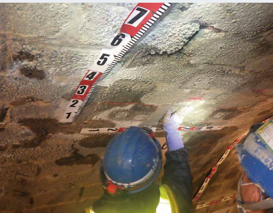
図15 止水用のモルタルを塗布する方法 4)
